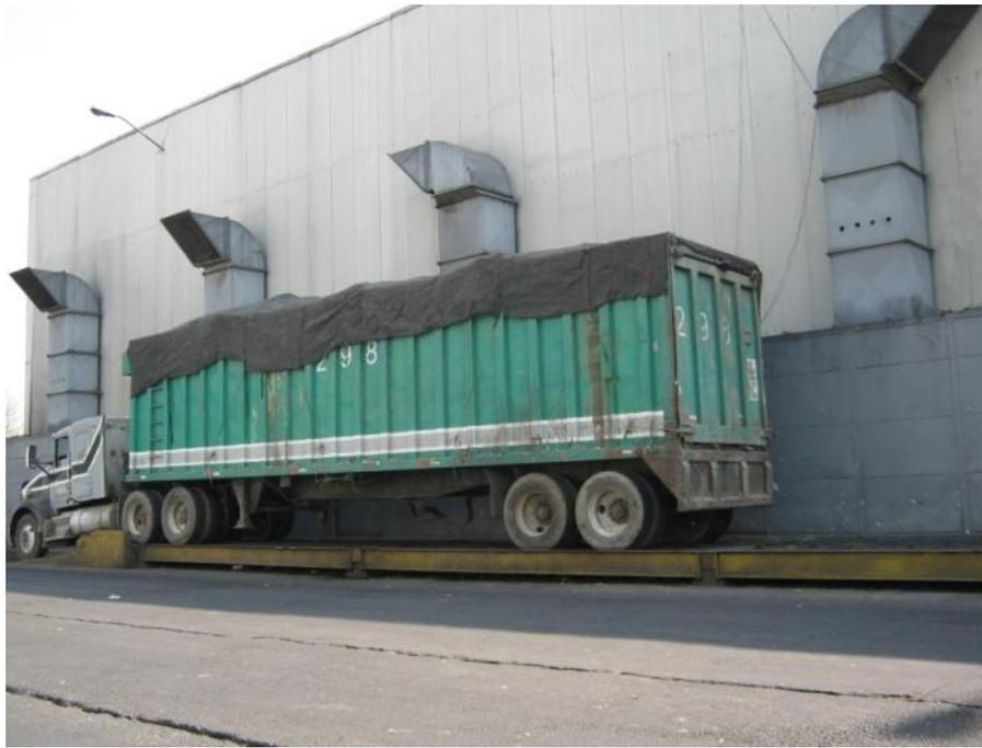
**Figura 56.** Estación de transferencia. Área CEDA - Iztapalapa. Báscula para pesaje de cajas con destino al RSBP.
